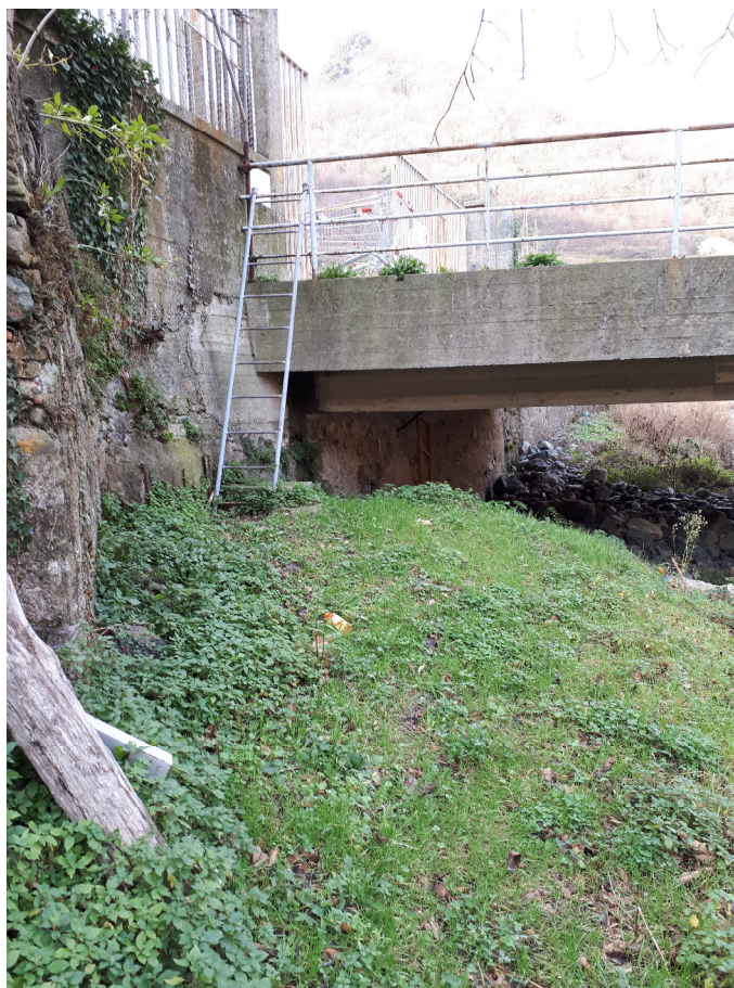
Foto 3 – Discesa da Ponte di accesso a Centrale E-distribuzione a terrapieno sottostante in alveo.
